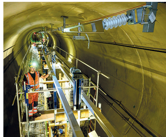
Deckenstromschienenmontage im Koralmtunnel
