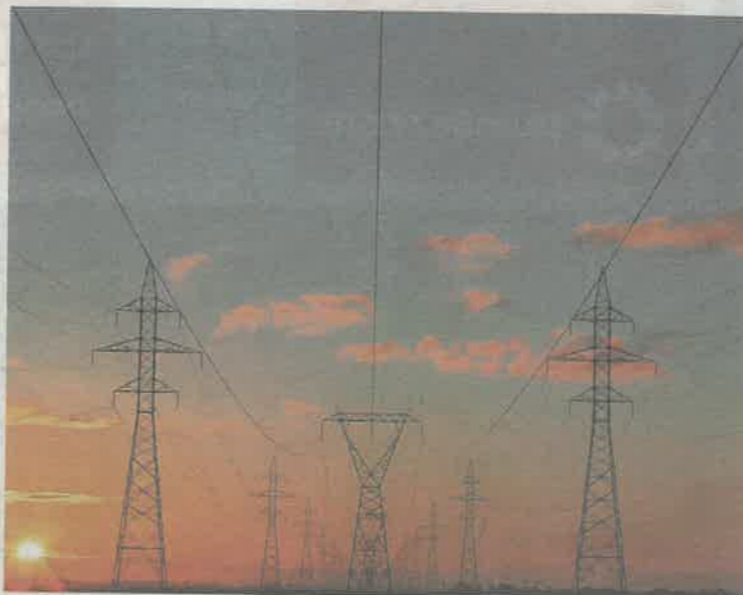
Das Großprojekt soll in drei Bauabschnitten von 2024 bis 2026 erfolgen.
